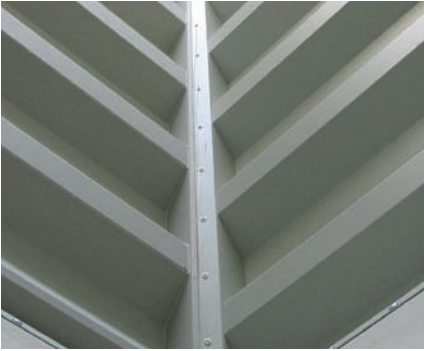
Bild 4: Patentierte Wandelemente-Verbindung im OCTOGON-Dammwandsilo
