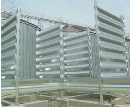
Bild 2: OCTOGON-Dammwandsilo, vormontierte Wandelemente B = 3,55 m
