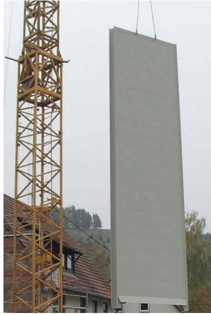
Bild 3: OCTOGON-Glattwandsilo, Wandelement 3 m x 11,7 m
