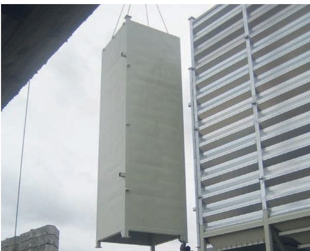
Bild 1: OCTOGON-Glattwandzelle 2,5 m × 2,5 m × 8,5 m
