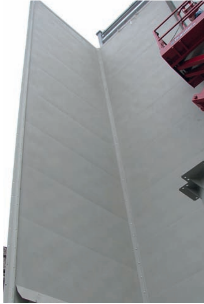
Bild 5: Patentierte Wandelemente-Verbindung im stoßfugenfreien OCTOGON-Glattwandsilo
